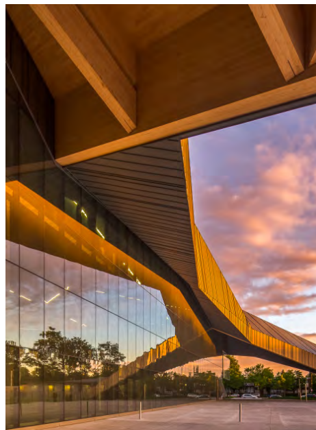
Stade de Soccer de Montreal, Saucier + Perrotte Architects + Hughes, Condon, Marler Architects
