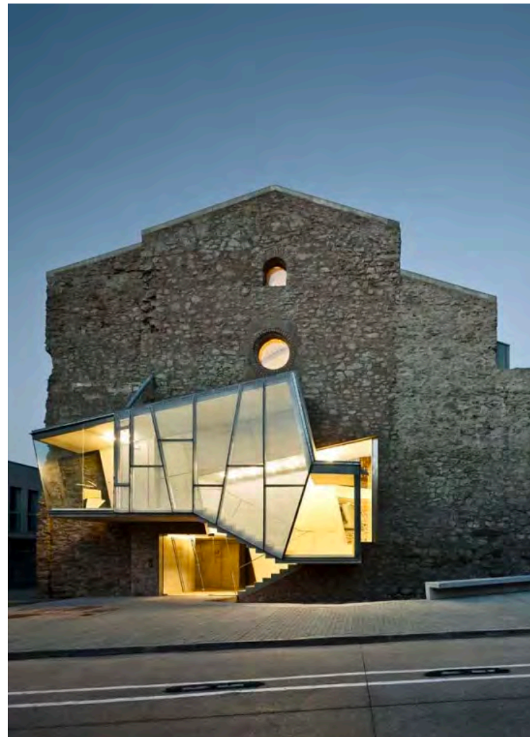
AUDITORIO EN EL CONVENTO DE SANT FRANCESC, Spain, David Closas
